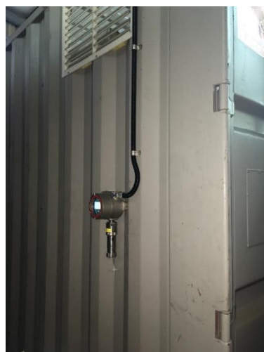
裝設固定式氣體偵測器
