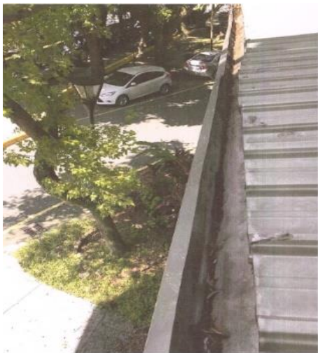
屋頂排水溝清理
